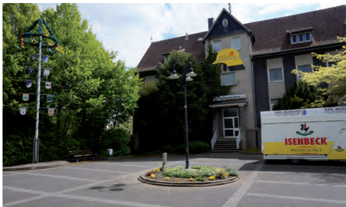
Gebäude der Freiwilligen Feuerwehr an der Route Rundwanderweg
