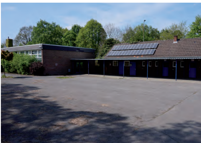
Ehemalige Ermeling Grundschule
