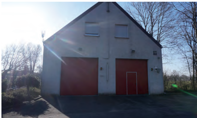
Gebäude der Freiwilligen Feuerwehr Osterbönen
