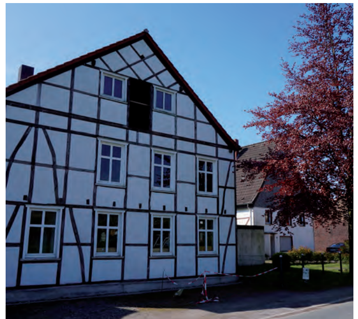
Fachwerkhaus in Flierich
