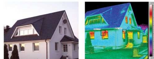
Zustand dieses Hauses nach der Sanierung
